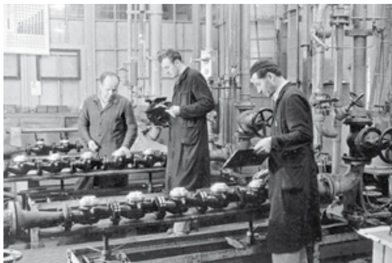
Skúšanie vodomero v n. p. PREMA, Stará Turá
